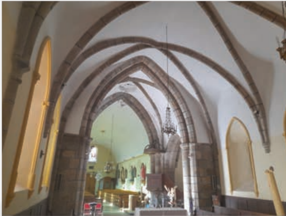
Photo intérieur du chœur en regardant vers la nef.
