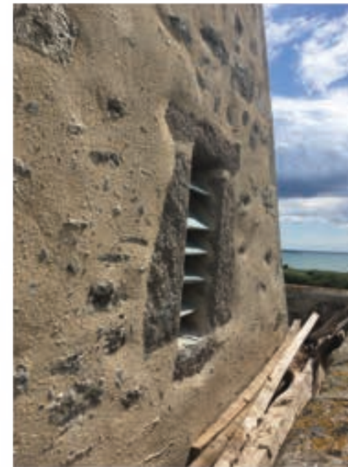
Restauration en cours d'une des façades du clocher, à gauche les parements dépiçtés, à droite les nouveaux joints à la chaux en cours de pose.
