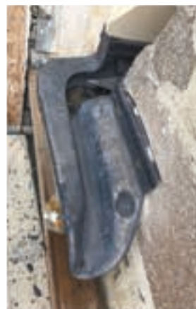
Vu sur une des gargouilles en plomb réalisé dans le remplacement des habillages en plomb des terrasses du clocher.
